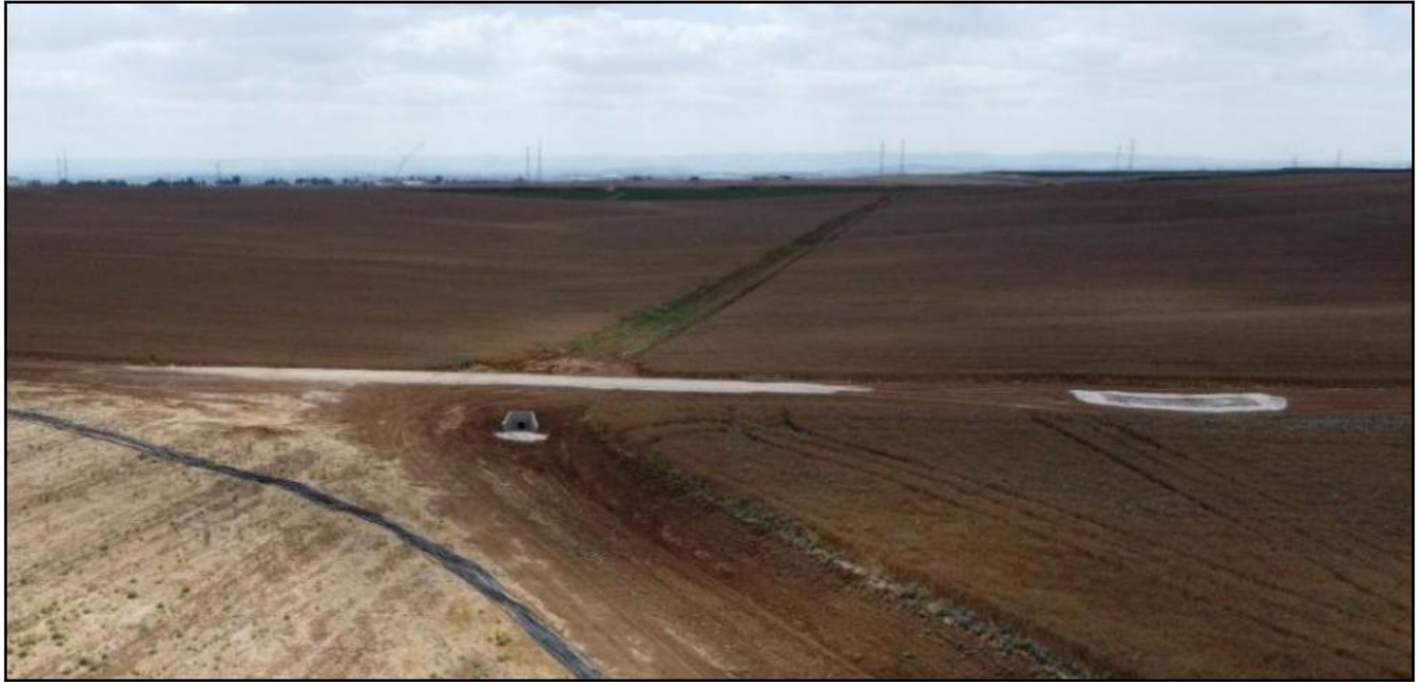
תרשים 4.5: מתקן ריסון בשטח מושב ניר חן, מבט לכיוון המעלה (יזם- ר.ג שורק לכיש, תכנון – הידרוגרין)
